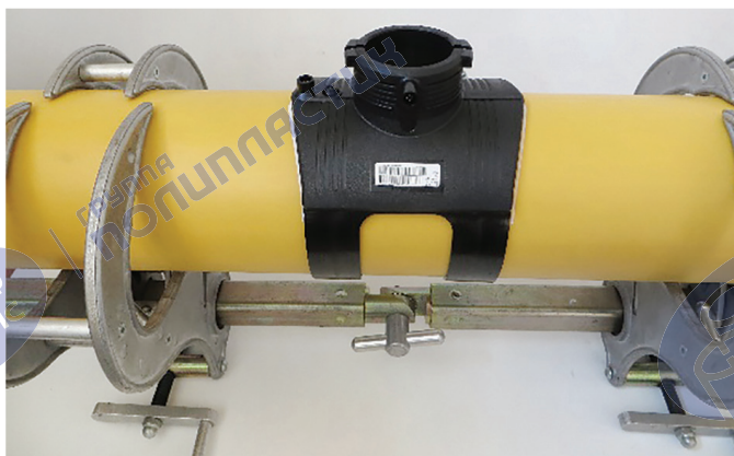
Рисунок 22 – Предварительная примерка седлового отвода
