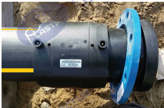
Рисунок 32 – Присоединение к трубе втулки под фланец с удлиненным концом при помощи муфты с ЗН
