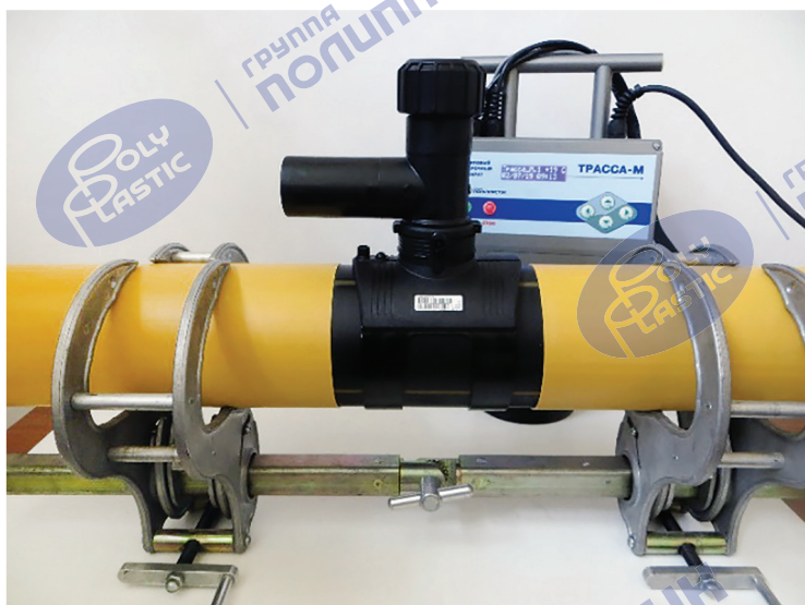
Рисунок 30 – Выполнение приварки седлового отвода
