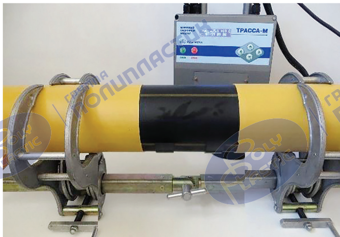
Рисунок 28 – Обезжиривание поверхности трубы
