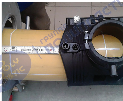
Рисунок 23 – Разметка границ снятия удаляемого слоя
