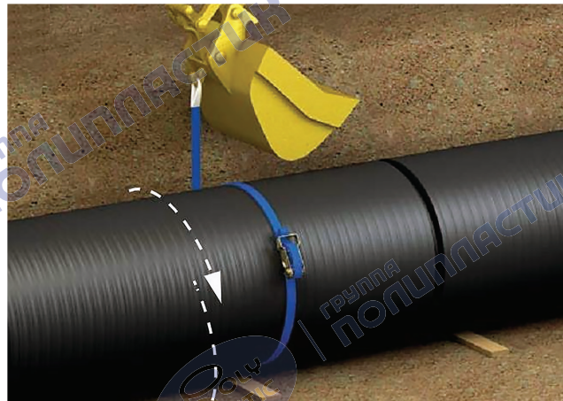
Рисунок 10 – Свинчивание соединения на резьбе с помощью стяжного ремня
