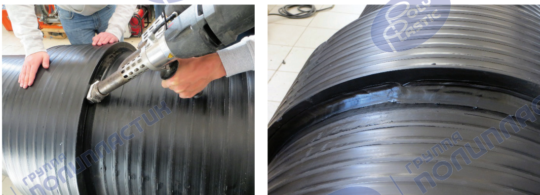
Рисунок 44 – Приварка муфты к трубе
