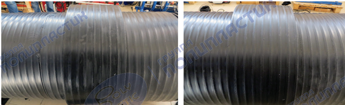
Рисунок 43 – Установка муфты на стык труб
