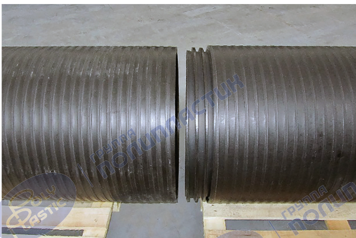
Рисунок 8 – Центровка труб перед сборкой соединения на резьбе
