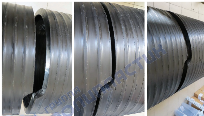
Рисунок 23 – Совмещение и центровка труб
