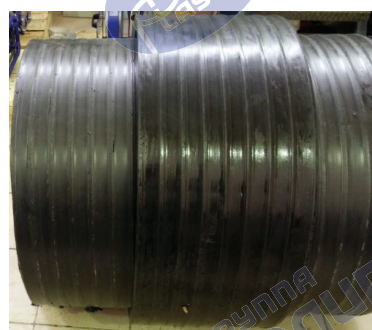
Рисунок 39 – Муфта, надетая на свободный конец трубы
