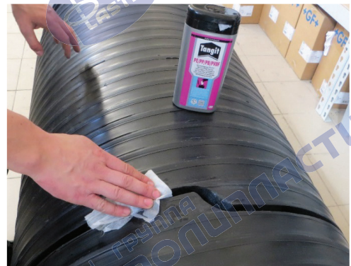
Рисунок 24 – Обезжиривание поверхности зоны стыка
