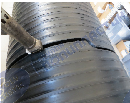
Рисунок 25 – Сварка шва с помощью ручного экструдера
