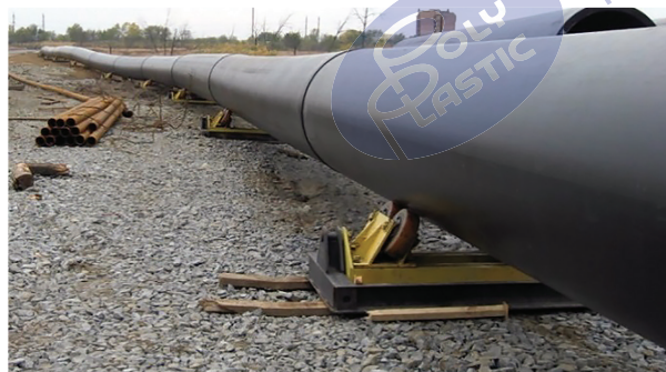
Рисунок 6 – Использование роликовых опор при прокладке трубопроводов
