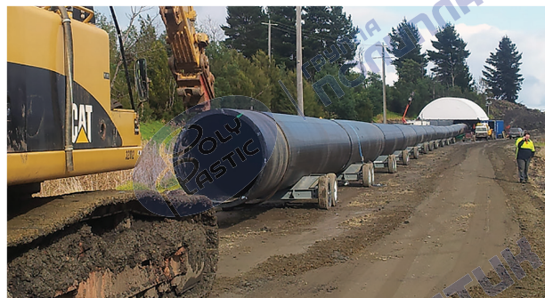
Рисунок 6 – Использование роликовых опор при прокладке трубопроводов
