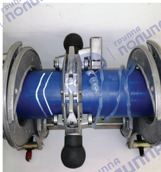
Рисунок 17 – Зачистка поверхностного слоя трубы
