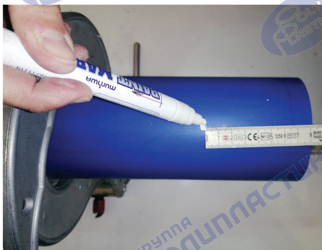
Рисунок 11 – Нанесение метки границы поверхностного слоя
