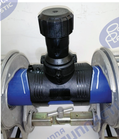
Рисунок 16 – Предварительная примерка седлового отвода и разметка границ снятия поверхностного слоя
