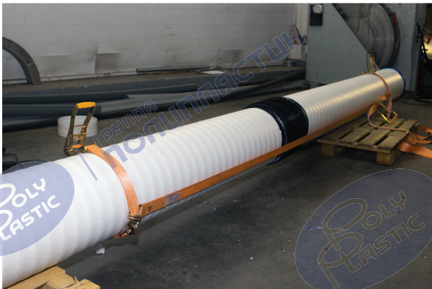
Рисунок 27 – Использование стяжных ремней для соединения труб
