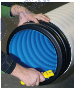
Рисунок 21 – Обработка торцов труб циклей
