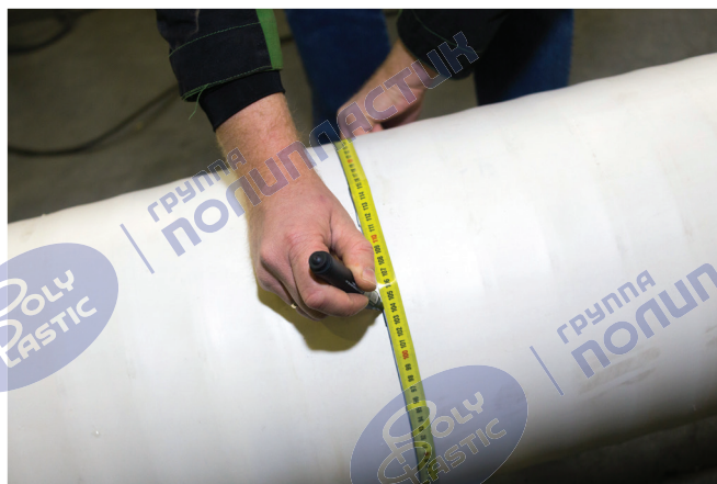
Рисунок 17 – Подготовка к разрезу трубы
