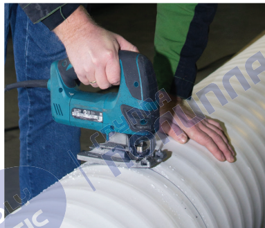
Рисунок 19 – Разрез трубы с помощью лобзика
