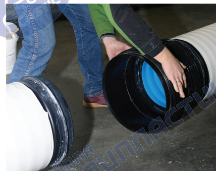
Рисунок 26 – Соединение труб
