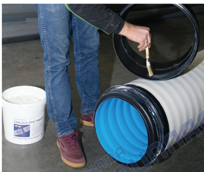
Рисунок 24 – Нанесение «смазки-лубриканта» на соединяемые поверхности
