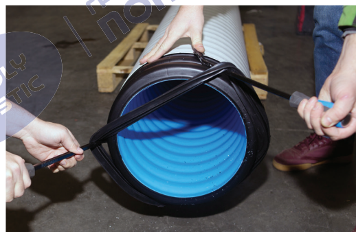
Рисунок 23 – Установка уплотнительного кольца с помощью монтировок
