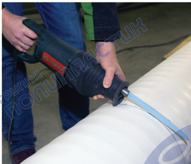
Рисунок 18 – Разрез трубы с помощью сабельной пилы
