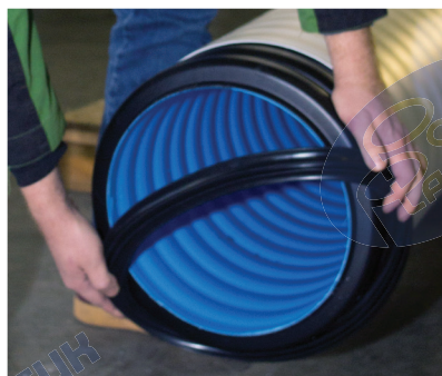
Рисунок 22 – Установка уплотнительного кольца во впадину между гофрами
