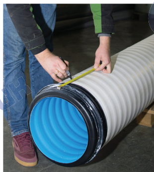
Рисунок 25 – Нанесение отметки глубины захода в муфту
