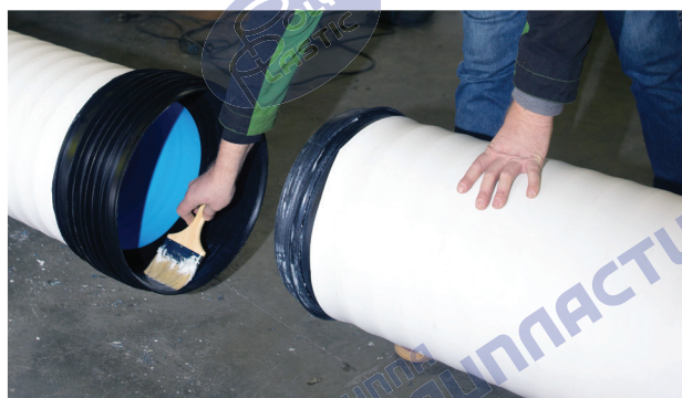
Рисунок 33 – Покрывание соединяемых поверхностей «смазкой-лубрикантом для монтажа полимерных труб»
