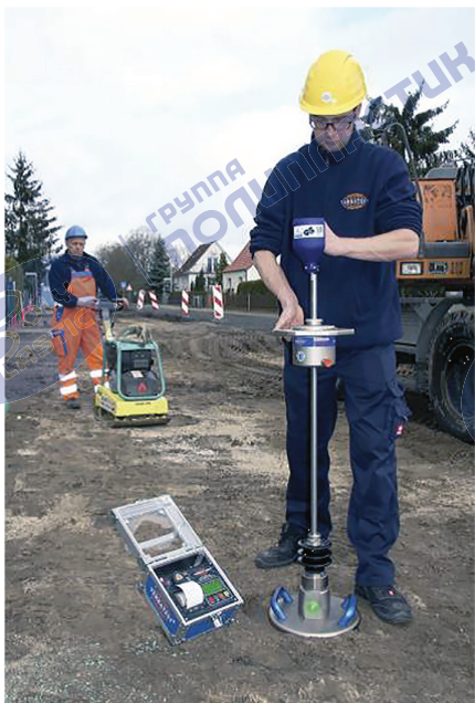
Рисунок 39 – Измерение степени уплотнения грунта при помощи статического плотномера
