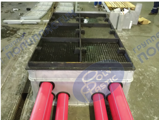
Рисунок 23 – Многоканальное подсоединение труб в МДПС
