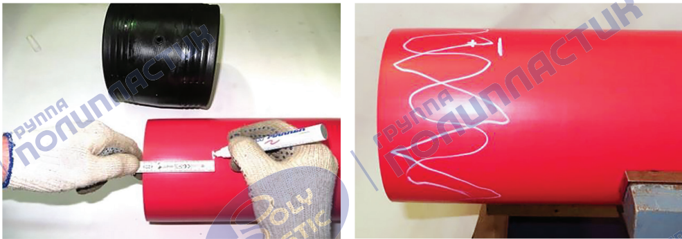
Рисунок 13 – Разметка границ зачистки поверхностного слоя
