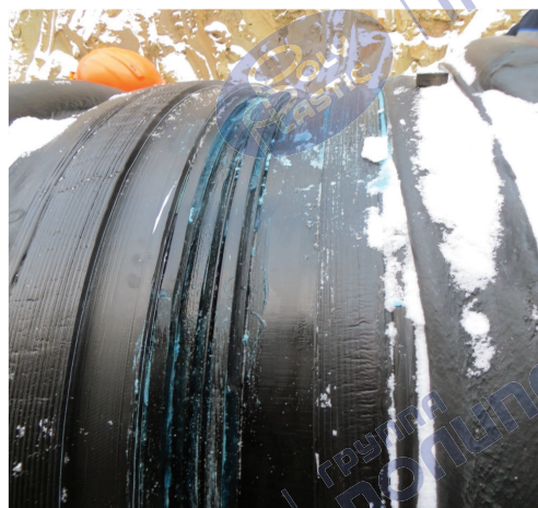
Рисунок 17 – Обработка торцов труб смазкой
