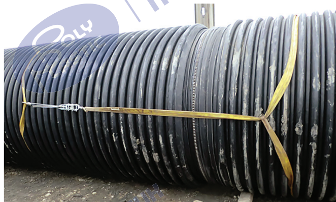
Рисунок 10 – Применение ручных лебедок, и/или стяжных ремней для стыковки и фиксации свариваемых труб
