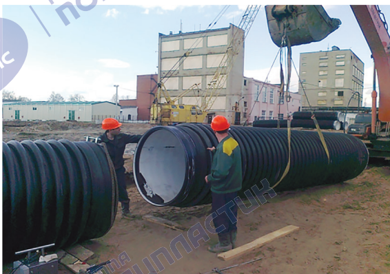
Рисунок 9 – Применение техники для стыковки труб
