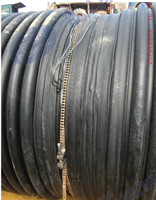
Рисунок 7 – Расположение цепного стяжного устройства и адаптера подключения сварочного аппарата
