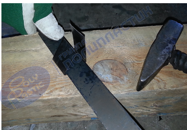
Рисунок 21 – Установка замка на бандажную ленту
