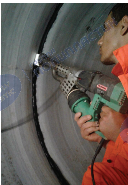
Рисунок 20 – Фиксация соединения с помощью ручного экструдера
