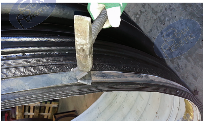
Рисунок 23 – Фиксация замка бандажной ленты
