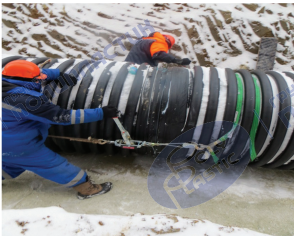
Рисунок 18 – Использование стяжных ручных лебёдок для стыковки труб
