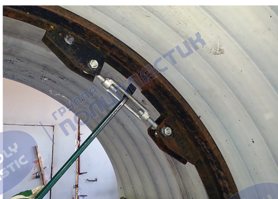
Рисунок 26 – Разжатие колец
