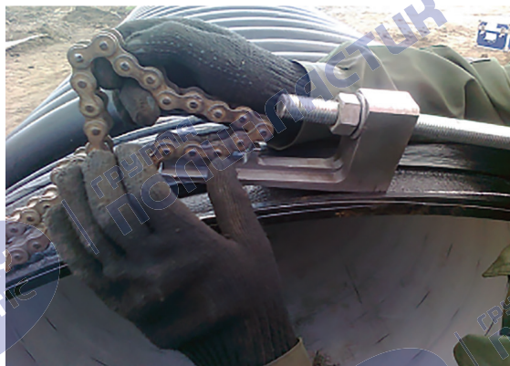
Рисунок 6 – Установка цепного стяжного устройства
