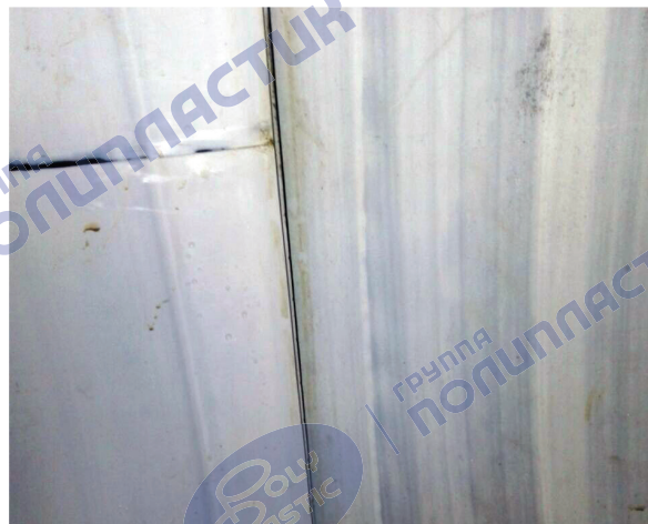
Рисунок 19 – Внутренний зазор между торцами труб
