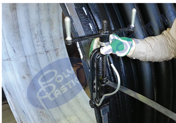
Рисунок 22 – Установка бандажной ленты
