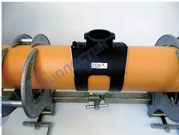
Рисунок 16 – Предварительная примерка седлового отвода
