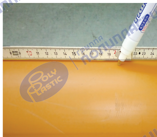
Рисунок 11 – Нанесение метки границы зачистки поверхностного слоя
