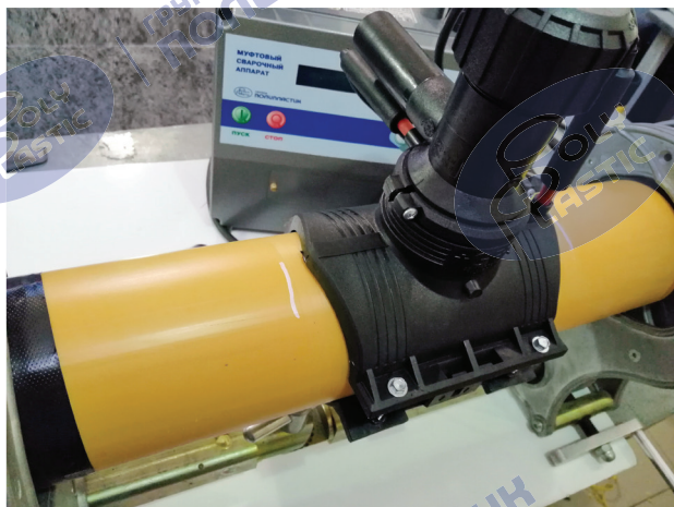
Рисунок 20 – Выполнение приварки седлового отвода
