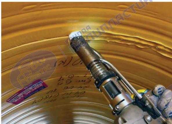
Рисунок 20 – Сварка соединения ручным экструдером
