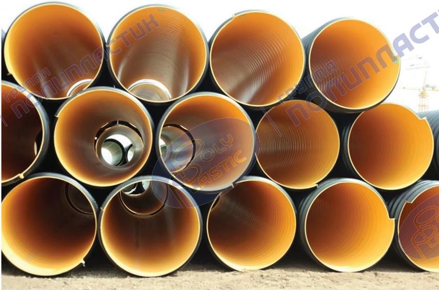
Рисунок 4 – Пример хранения труб «КОРСИС АРМ» в условиях строительной площадки на открытом местном грунте
