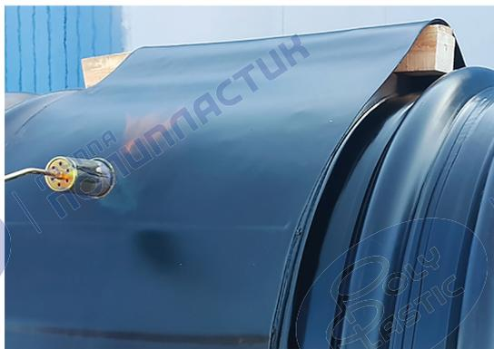
Рисунок 18 – Усадка ТУМ при помощи горелок
