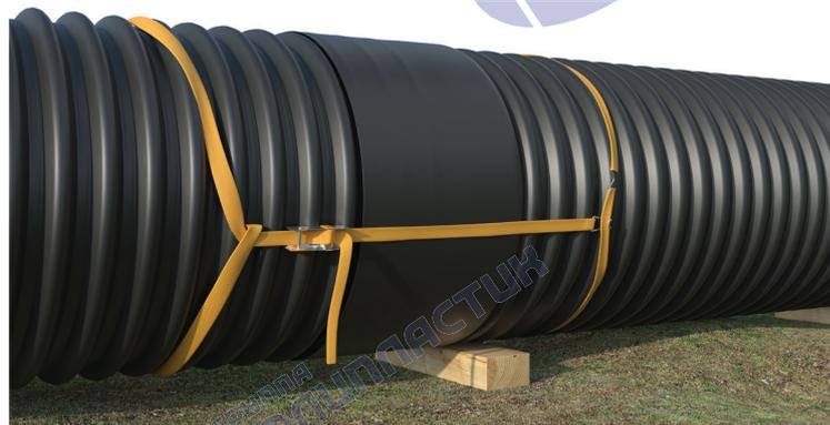
Рисунок 10 – Фиксация стяжными ремнями соединяемых труб «КОРСИС АРМ»
