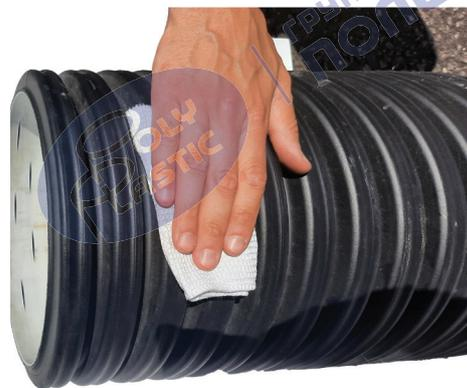
Рисунок 19 – Очистка поверхности конца трубы
