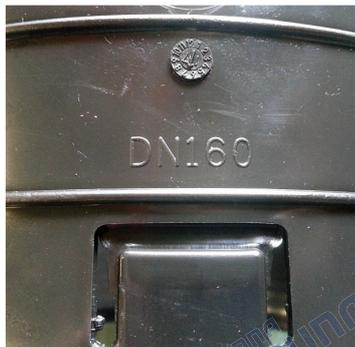
Рисунок 10 – Пример маркировки муфты с защелками
