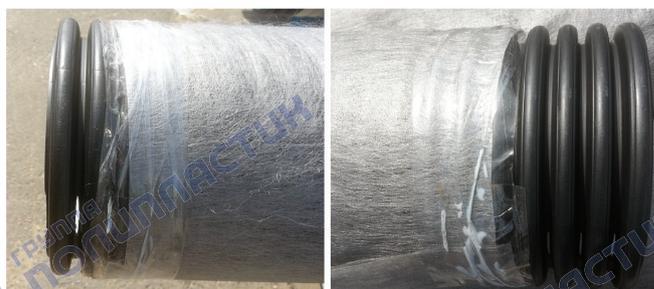
Рисунок 30 – Подготовка концов трубы ПЕРФОКОР с ЗФП к монтажу
