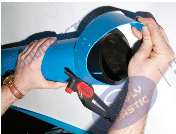
Рисунок 6 – Снятие защитной оболочки с использованием плужкового ножа
