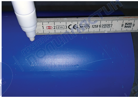
Рисунок 9 – Нанесение метки границы защитной оболочки
