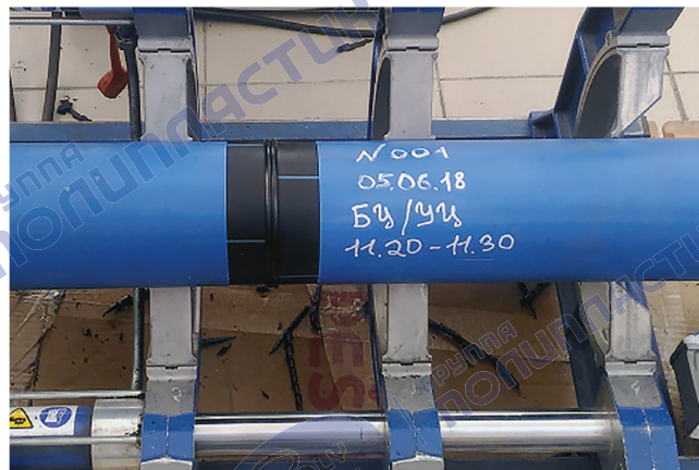
Рисунок 7 – Пример маркировки сварного соединения
