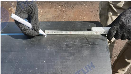
Рисунок 5 – Отметка длины посадки муфты
