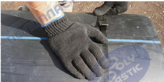
Рисунок 4 – Измерение диаметра трубы
