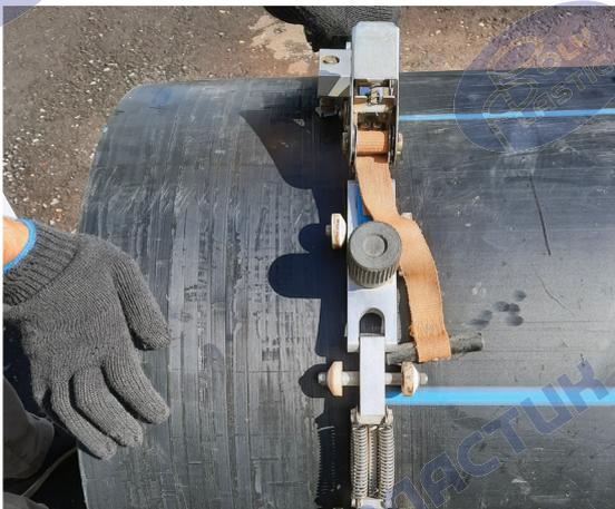
Рисунок 6 – Зачистка поверхности трубы
