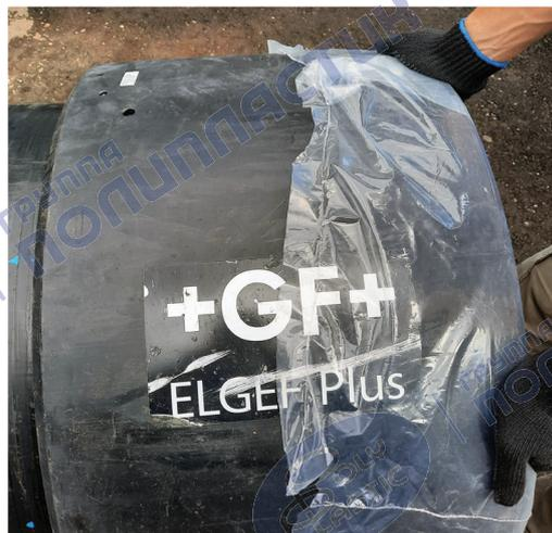
Рисунок 8 – Посадка муфты на трубу
