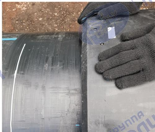
Рисунок 10 – Муфта GF с активным упрочнением
