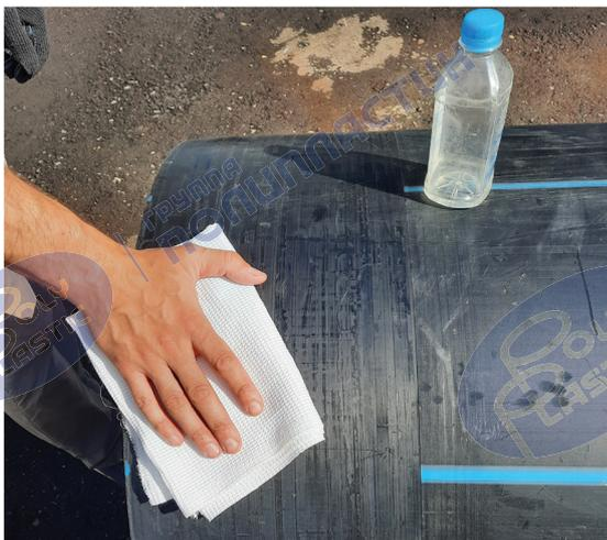
Рисунок 7 – Обезжиривание поверхности трубы
