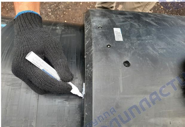
Рисунок 9 – Отметка конечного положения надвинутой муфты
